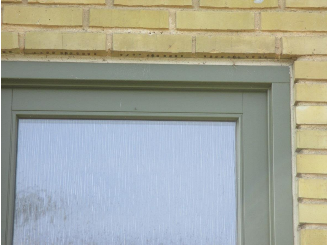
Foto 6. "Overligger" udført af hulsten.
