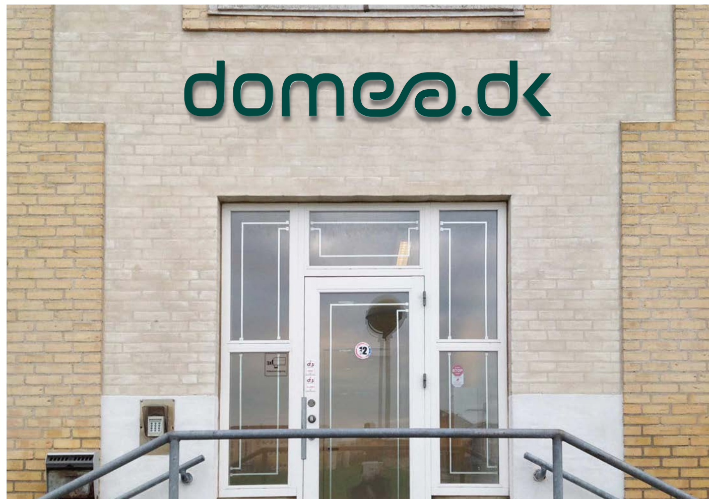
Bogstaverne sættes på facaden, hævet ud fra muren via "søm" der er forbinder mur og bogstaver.
