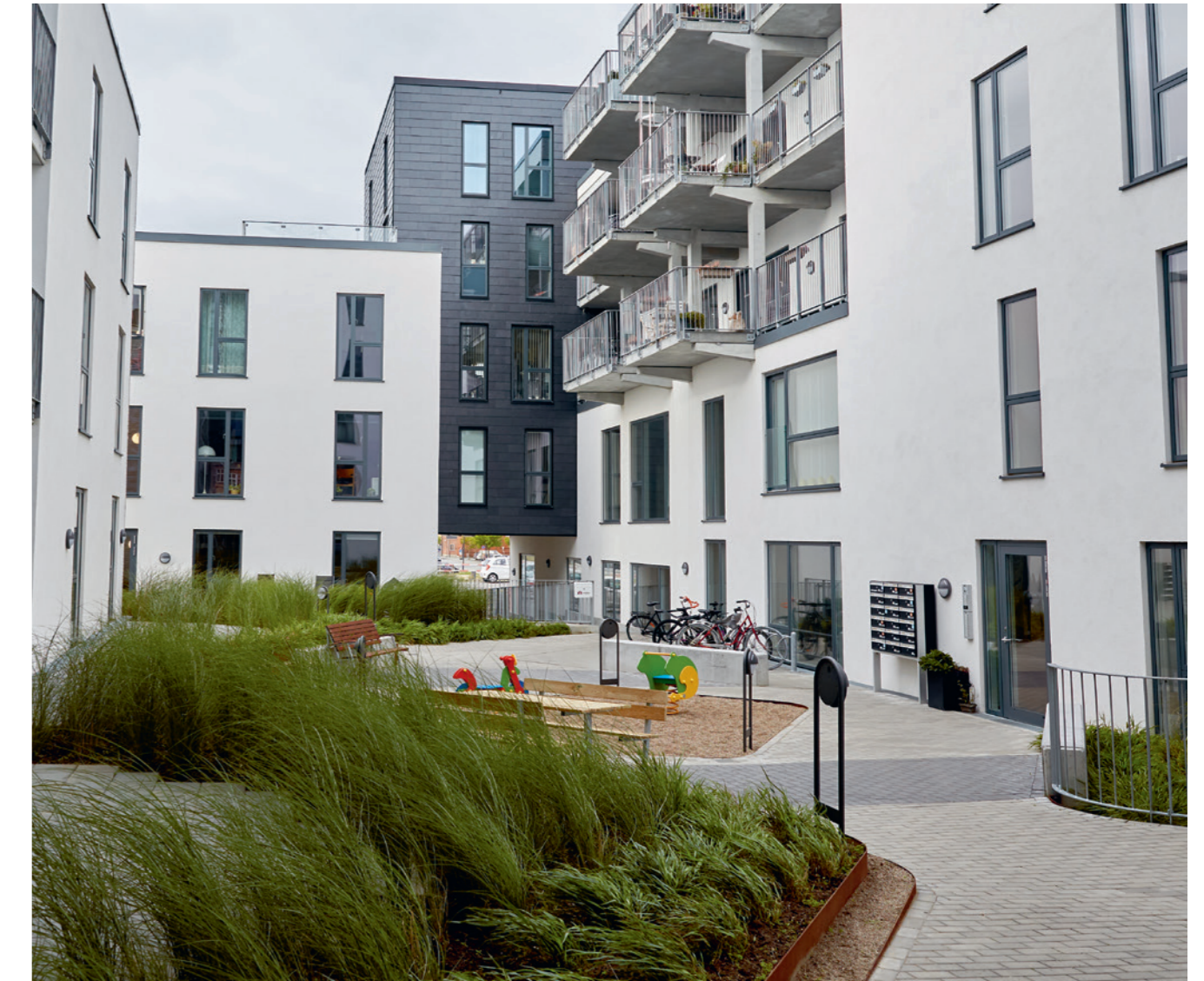
Frederikshuset er en boligbebyggelse i Fredericias nye kanalby. Bebyggelsen er en blanding af private og almene boliger placeret omkring et fælles gårdrum. Her mødes beboere på tværs af ejerforhold med samme attraktive og centrale placering ved vandet. Arkitekt: Rambøll/ON+PSL. Ingeniør: Oluf Jørgensen; samarbejdspartner Adsbøll Entrepriise. Bygherre: Boligselskabet Futura Fredericia
