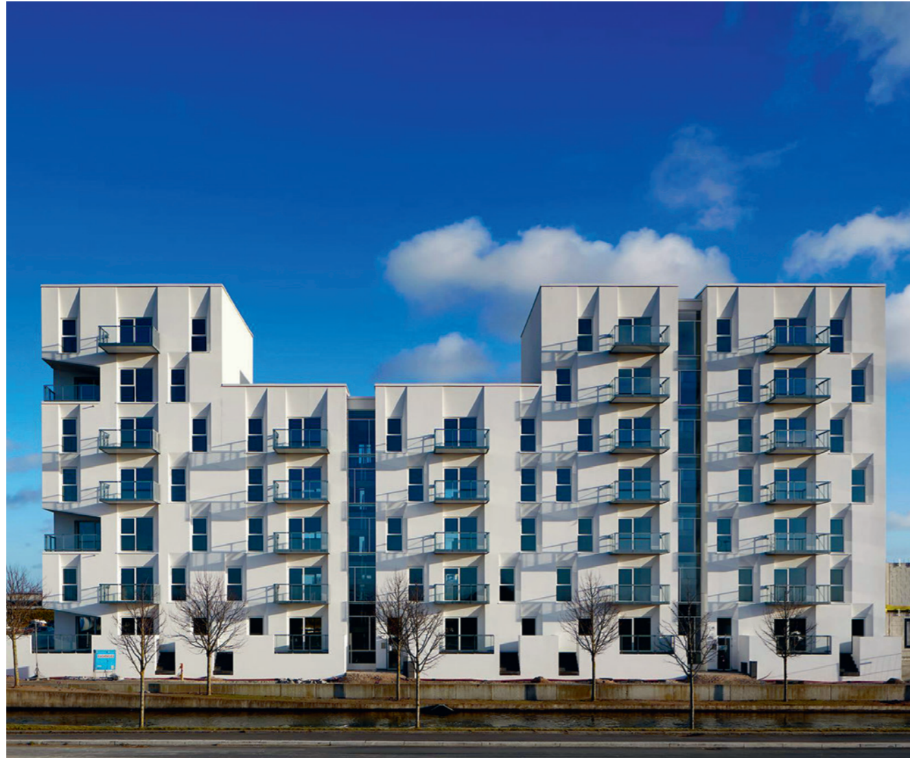
Ved Kanalen i Ørestad er et lavenergi-byggeri med solceller på et grønt tag. Byggeriet rummer 50 attraktive familieboliger. Arkitekt: Mangor & Nagel. Ingeniør: Oluf Jørgensen A/S. Bygherre: Boligselskabet Domea København
