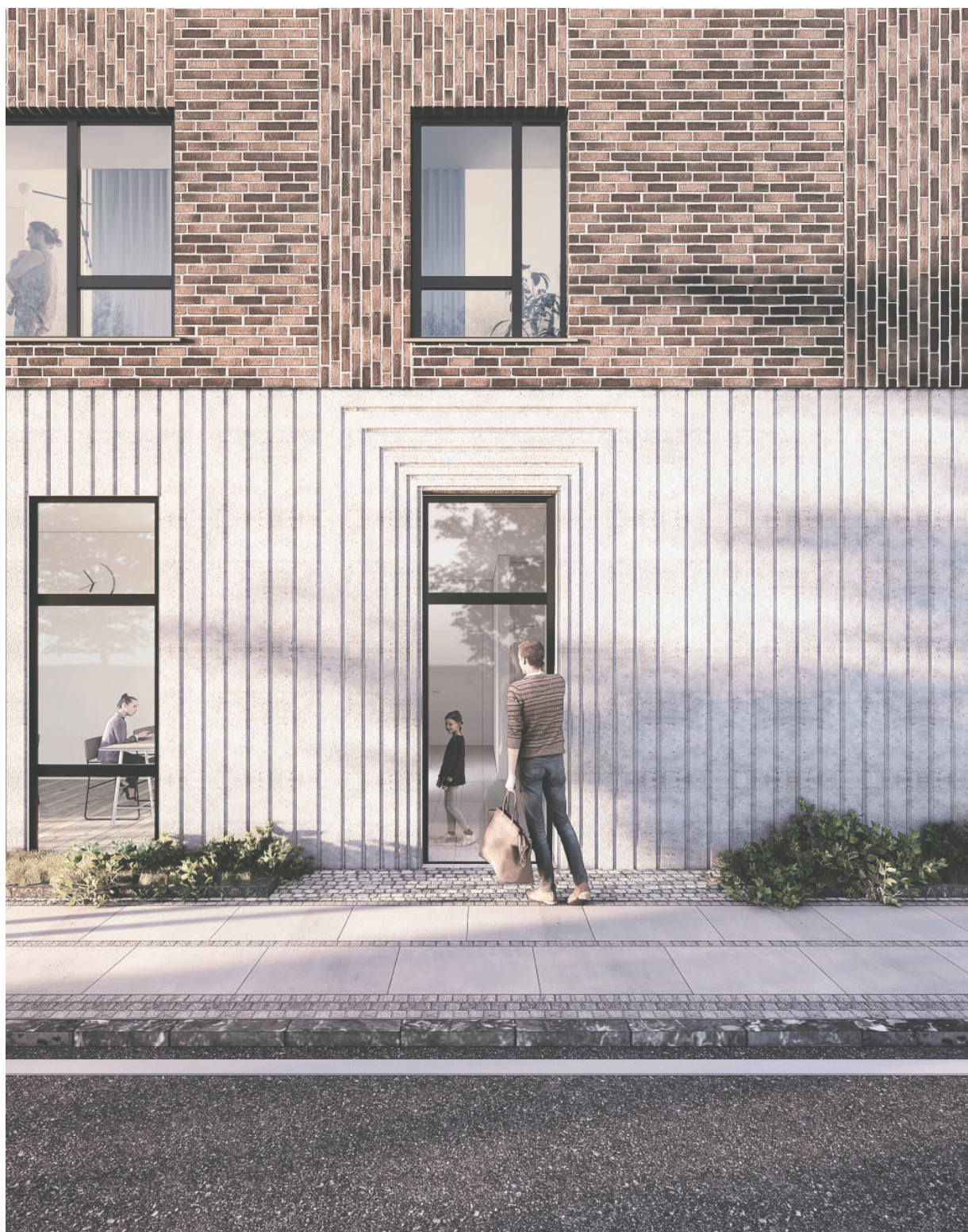
Eksempel på indgangsparti, med stueetage i beton med relieffer
