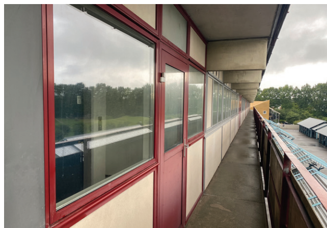
Eksisterende facade og svalegang, som skiftes.
