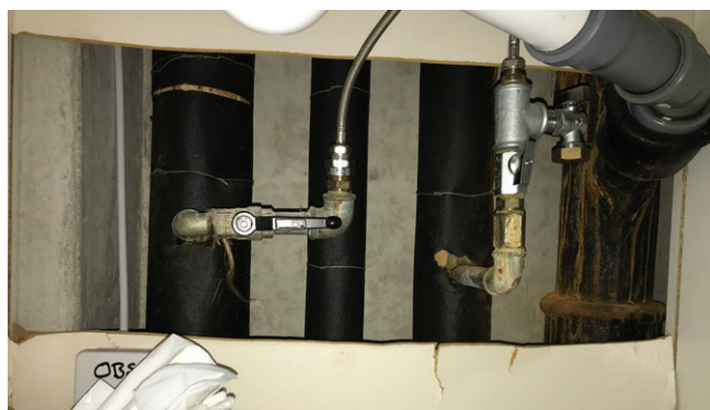
Eksisterende forhold, installationer bag køkkenelementer
