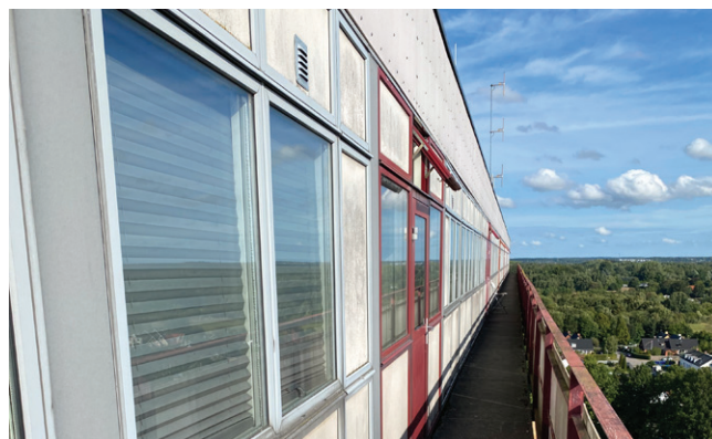
Eksempel på udskiftningsparate svalegangs-facader og vinduer
